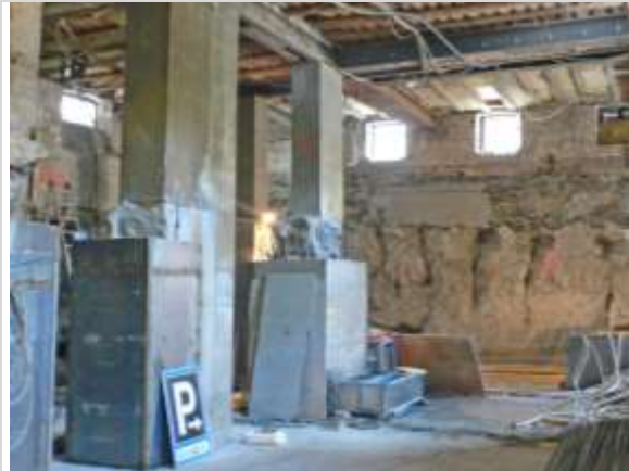
Foto 1. Utgraving under gammel kjeller. Forsterkning av oppstikkende jetpeler med stålmantel og støp mellom pel og mantel før støping av ny konstruksjon over pelene.
