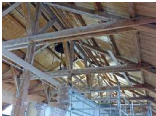
Foto 2. Rehabilitering av det store gamle taket. Oversikt av situasjonen under mønet.
