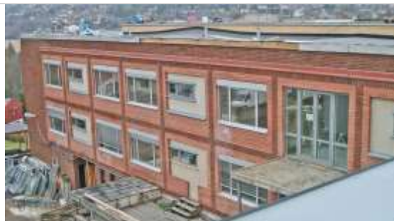
Foto 1. Døhli sykehjem under ombygging i 2003.
