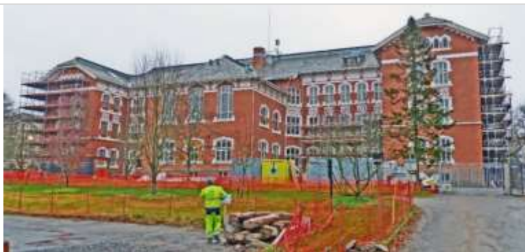
Foto 1. Kontroll av prosjektering og utførelse i kontrollområdene geoteknikk, konstruksjonssikkerhet og bygningsfysikk. Stor ombygging av UMB Urbygning på Ås i 2014. Byggherre: Statsbygg.
