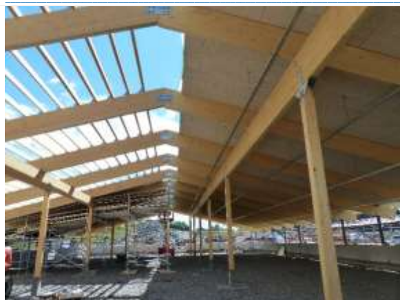
Foto 1. Søyler, bjelker og tak under bygging av hus for storfe
