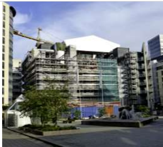
Foto 1. Bilde av ombyggingen i august 2014
