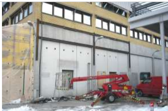
Foto 1. Utvendig forsterking av fasade på CCVest før den store gamle bærende yttervegg med betongelementer ble revet og erstattet med en ny fasade med store glassfelt. Alt mens etasjene over var i full bruk.
