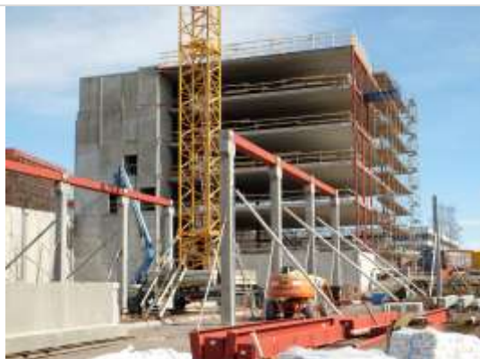
Foto 1. Bæresystem for kontor- og lagerbygg i april 2014
